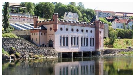
Photo: GodtSagt/Tinfos, Tinfos II, Powerstation
